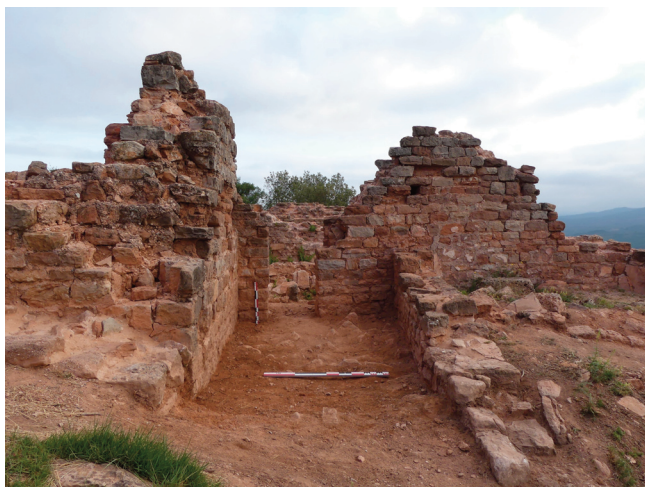
Vista del passadís d'accés a l'església amb el mur del dipòsit número 2 a la dreta
