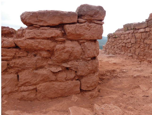
Detall de la diferència de parament entre la part inferior amb cantonada arrodonida i la superior amb cantonada quadrada
