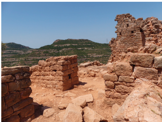
Vista de l'entrada de la nau amb el forat per la biga situat a una de les parets de la porta
