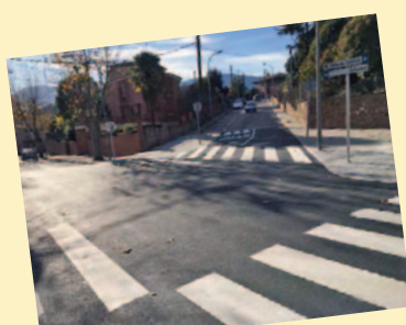
Obres ctra. Monistrol, av. Catalunya i marquesines
