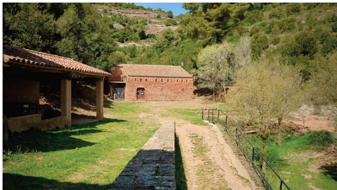
La Pahisa del Marquet, situada al costat de la masoveria.
